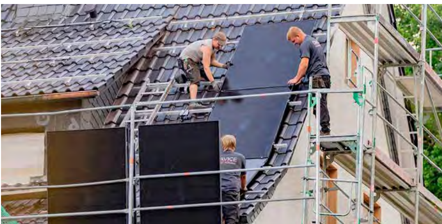
Rundumsorglos-Paket: von der Dachsanierung über die PV-Installation bis hin zur Elektrotechnik aus einer Hand.
