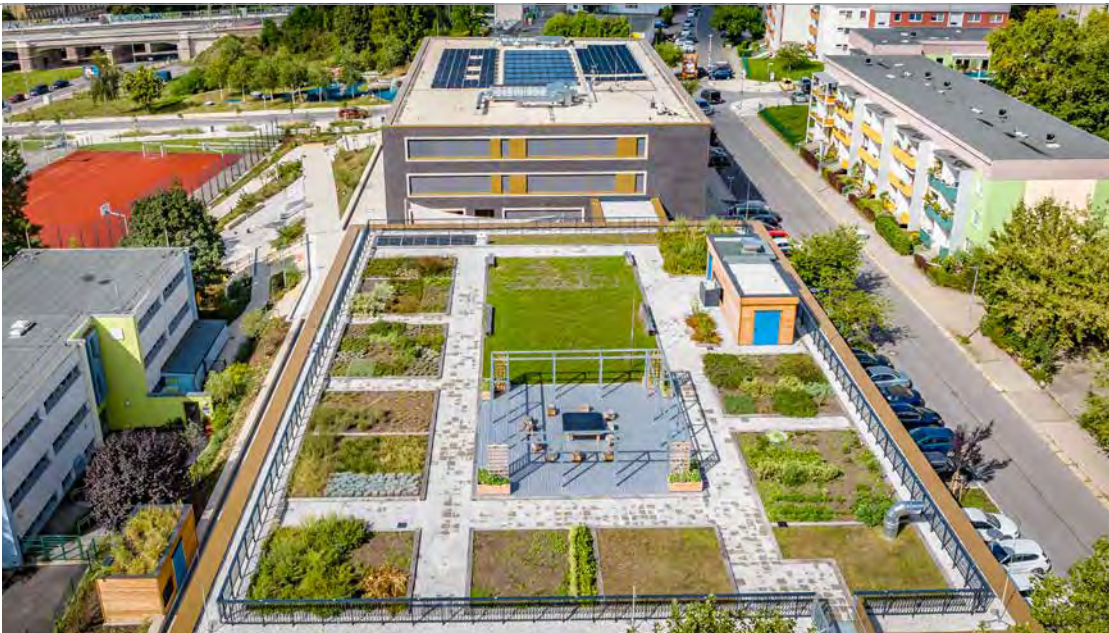
Das Flachdach dieser Grundschule in Chemnitz wird zum Schulgarten und damit zum Lernort im Freien.
