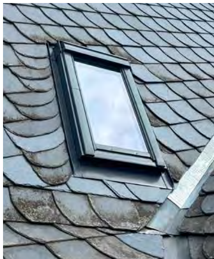
Zwei Mitarbeiter waren einen Tag lang beschäftigt, haben das defekte Material ausgetauscht und das Dach wieder fachmännisch verschlossen.
