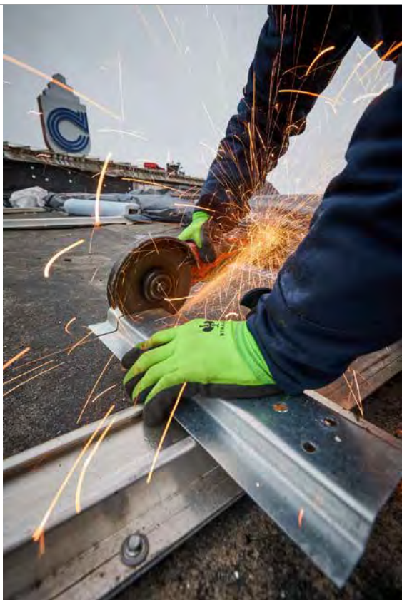
Zuschneiden vor Ort auf der Baustelle.
