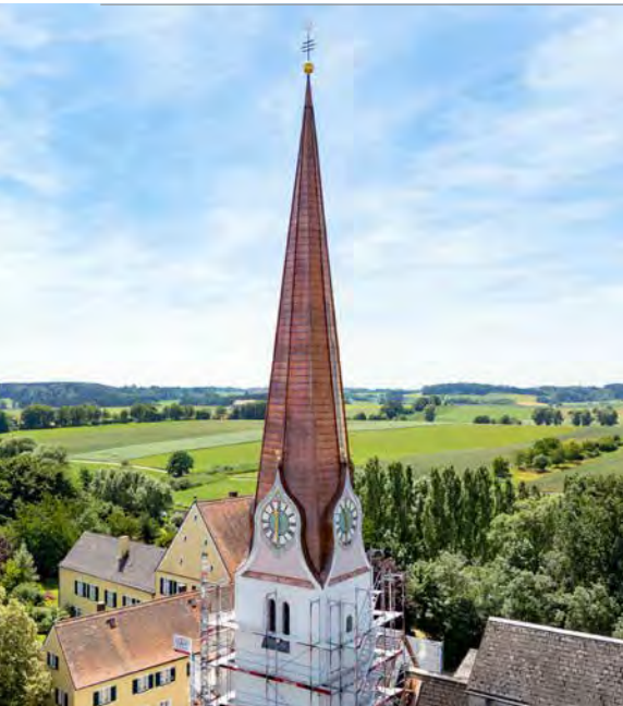
Kirchturm in Querbanddeckung mit liegenden Fälzen aus Kupfer.
