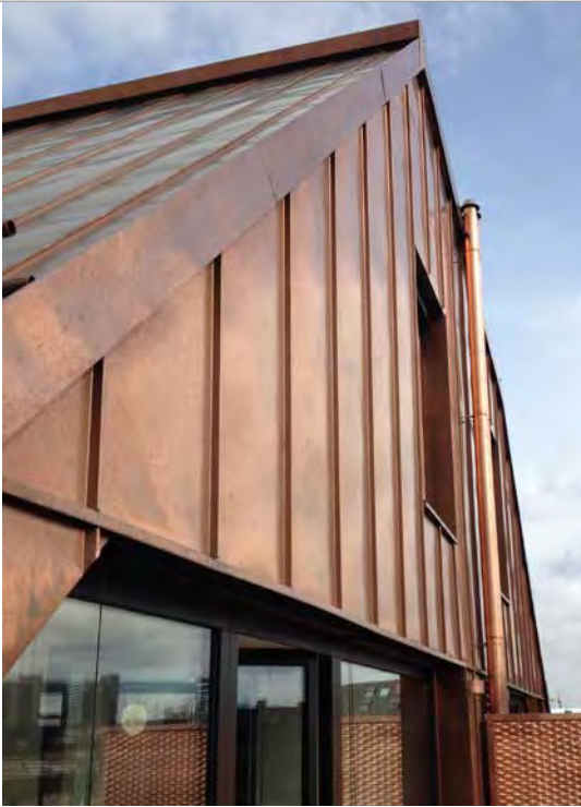
Stadthaus in München: Doppelstehfalzdeckung komplett in Kupfer.
