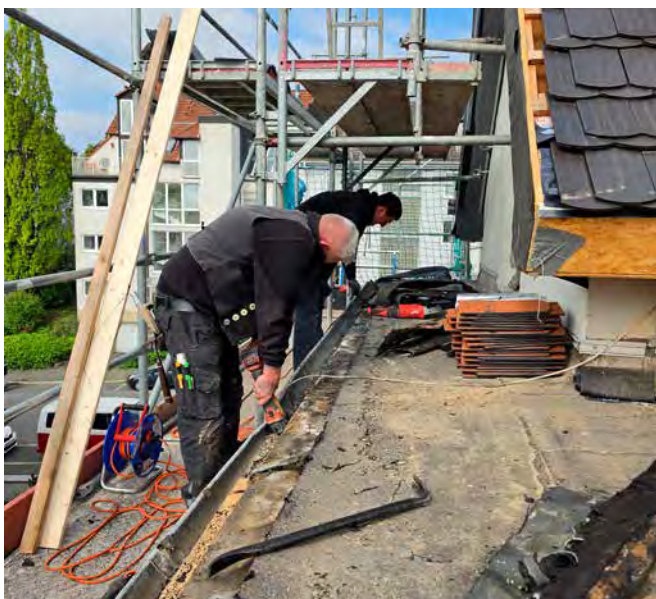
Fotos: Maik Kötter Dachdeckermeister
