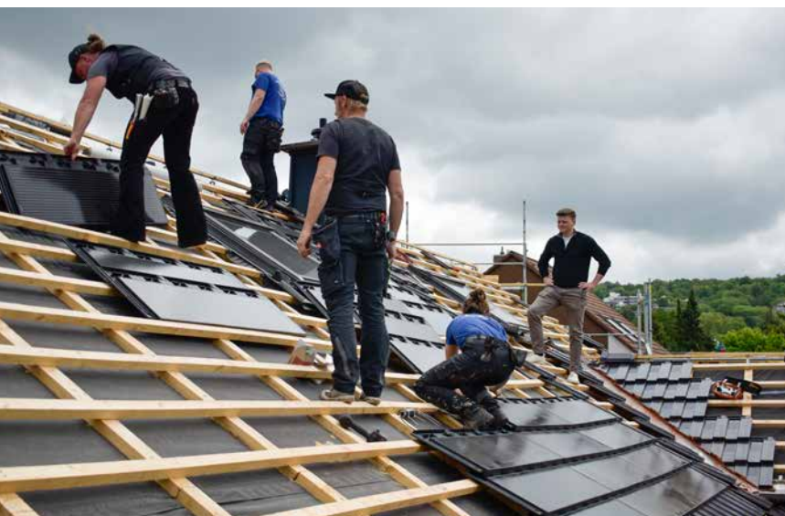
Juniorchef Kai Kahle (oben rechts) leitet die Baustellen bei Stolberg Bedachungen.
