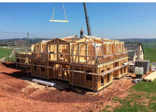
Zimmerei mit Holzbau ist ein wichtiges Standbein des Betriebs.
