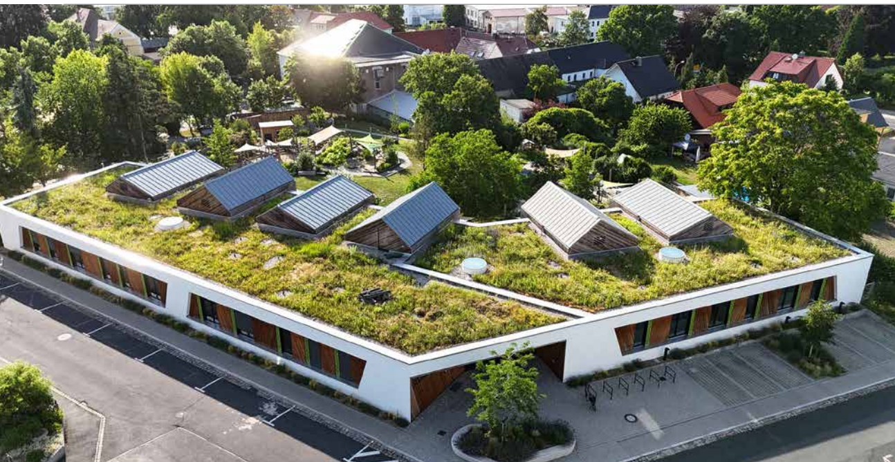
Luftaufnahme von der Kita Großenhain – Gründach des Jahres 2026.
