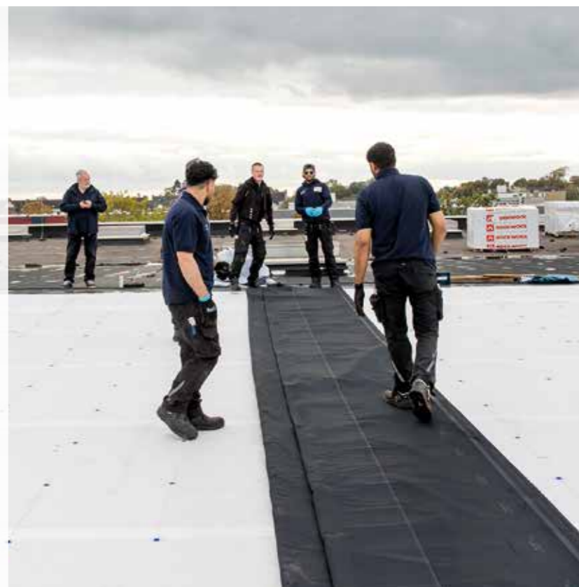
28 000 Quadratmeter Flachdach gilt es bei dem großen Industriekunden abzudichten.
