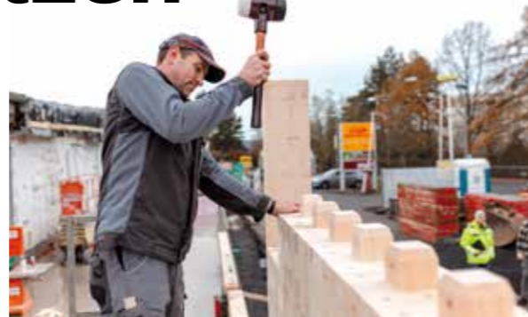
Die Holzbausteine sind leicht und schnell zu montieren.
