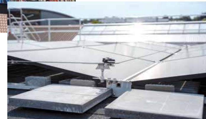
Eine Dachfläche mit Photovoltaikmontagesystem und integriertem Seilsicherungssystem.
