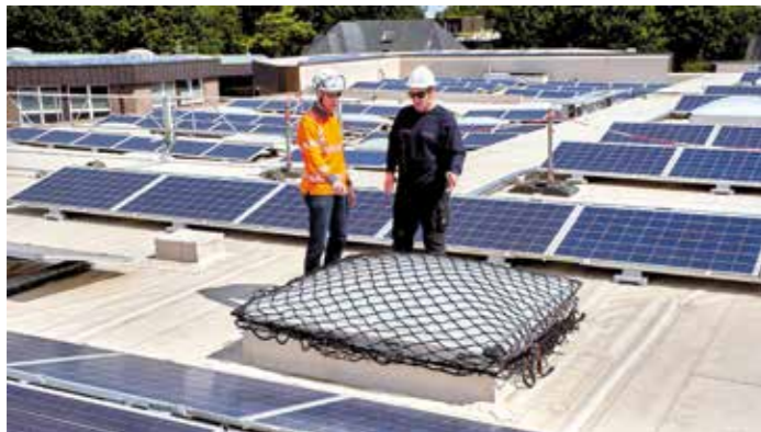
Über 6000 Absturzunfälle zeigen, dass eine bessere Prävention wichtig bleibt.
