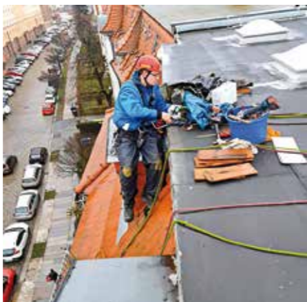
Hochkonzentriert bei Reparaturarbeiten an einer Gaube.
