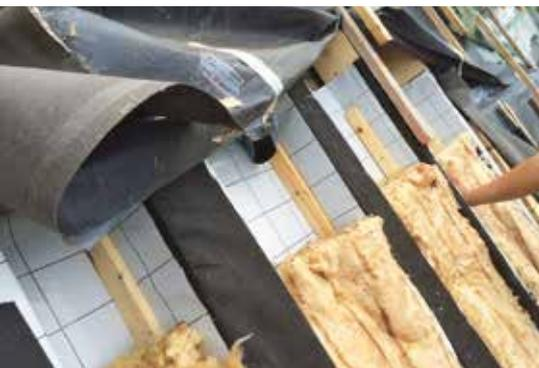
■ Dachaufbau, oben die provisorische Abdeckung.
