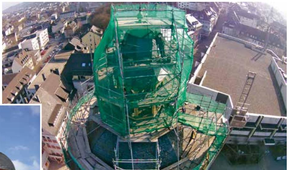
■ Vorher und nachher: Das untere Schloss in Siegen wird derzeit durch den örtlich ansässigen Dachdeckerbetrieb Gros + Zimmermann, Mitglied der DEG Alles für das DACH eG, Koblenz, völlig neu mit Moselschiefer eingedeckt.
