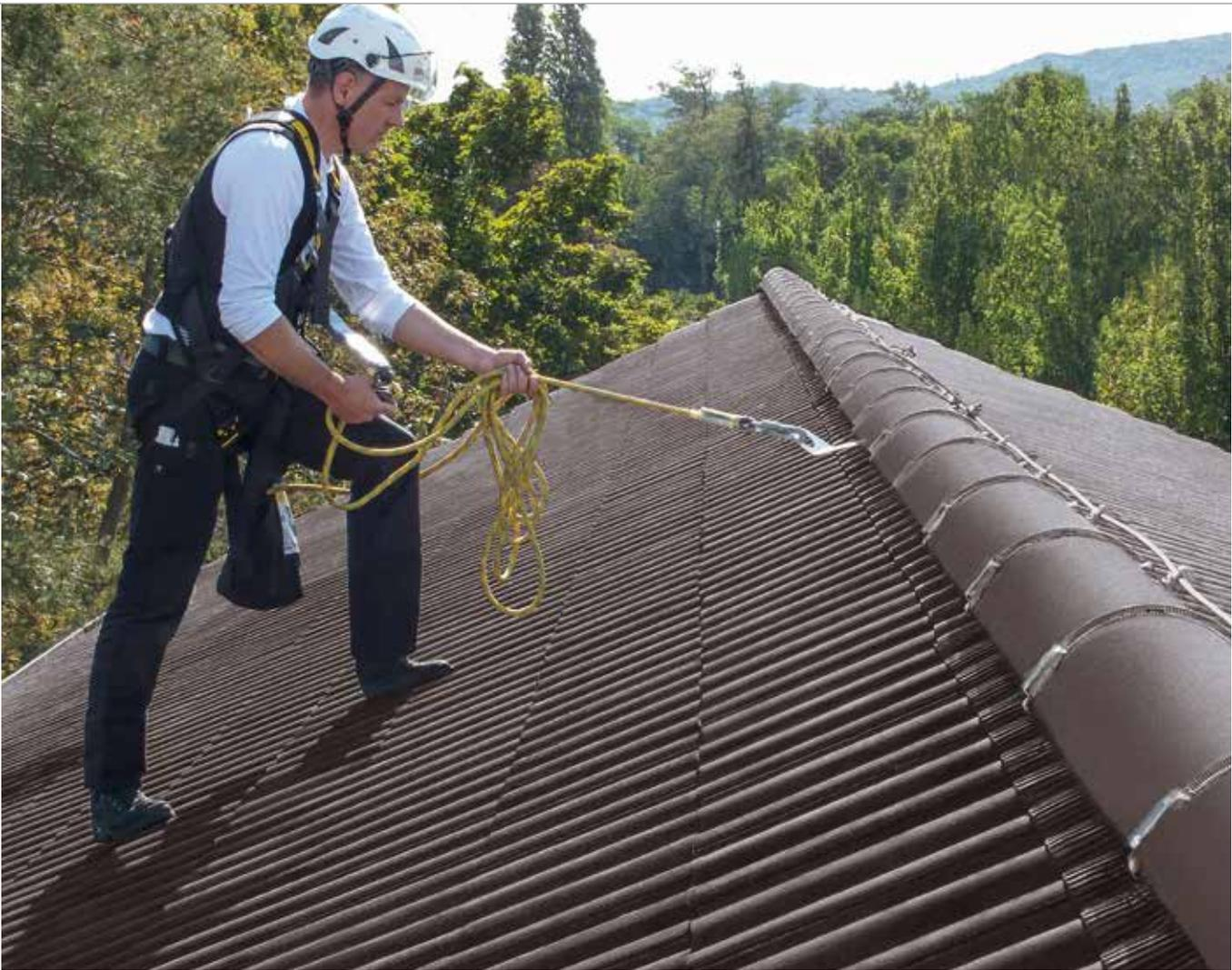
*TopSlide sichert eine Person pro installiertem System.*
