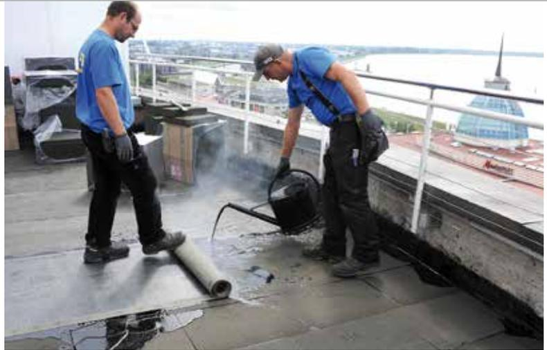
Präzises Arbeiten ist angesagt, wenn es um die Verklebung der einzelnen Schichten geht. 40 Pakete heißes Bitumen laufen durch die Gießkanne.
