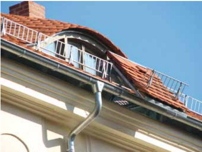
Architekt Tassilo Soltkahn erfindet eine Fluchtweggaube. Das Produkt funktioniert auch in der Praxis und schafft gerade für den Dachgeschossausbau unter Denkmalschutz einen zweiten Fluchtweg.
