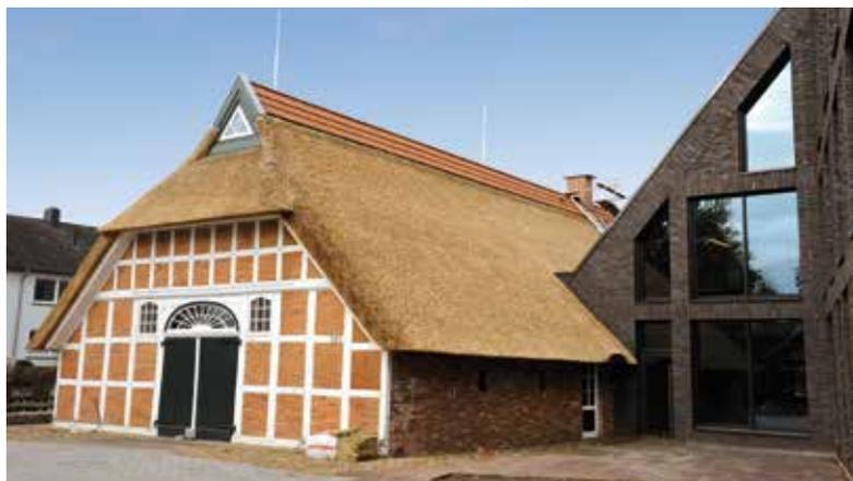
Gearbeitet wurde nur bei trockenem Wetter, denn das Reet darf beim Verlegen auf keinen Fall feucht werden. Man merkte den jungen Dachhandwerkern ihren Respekt vor dem geschichtsträchtigen Objekt an, das volle Konzentration bei der fachgerechten Ausführung verlangte.
