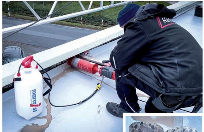
*Praxisbeispiel 2 Kernlochbohrungen mit der WCU750X Ø 122 mm durch 200 mm Stahlbeton mit dem Compact Set, 12 min./Bohrung*
