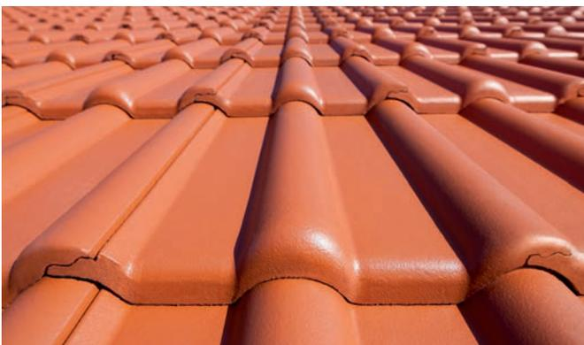
Für die Oberflächenveredelung in Star-Qualität werden die Dachsteine mit einer feinen Mikromörtelschicht überzogen. Auf diese Weise werden die Poren verschlossen. Das sorgt für eine hohe Widerstandsfähigkeit und der Dachstein erhält eine spürbar glattere Oberfläche. Unschöne Ablagerungen wie Algen und Moos bleiben durch die hochwertige Veredelung weniger haften. So behält die Dachpfanne länger ihr sauberes und ansprechendes Aussehen – über viele Jahre hinweg.
