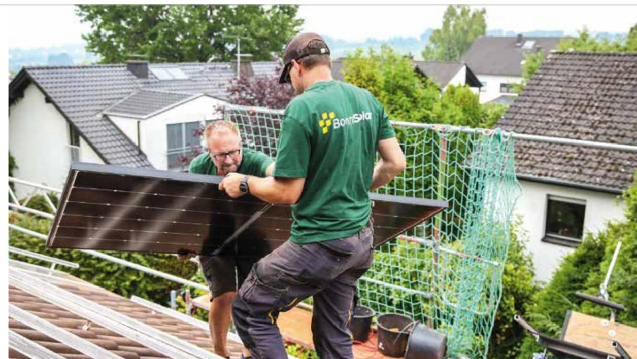
PV-Montage auf dem Steildach: Mitarbeiter von BonnSolar im Einsatz.
