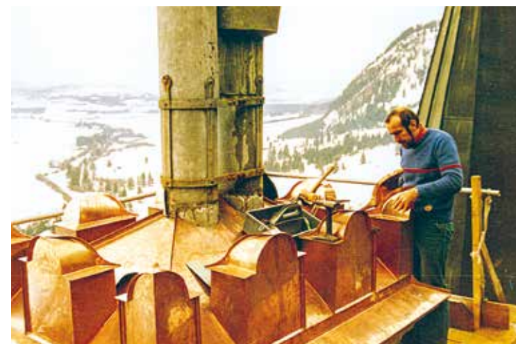
Hermann Loderer beim Falzen von Abdeckungen aus Kupfer.
