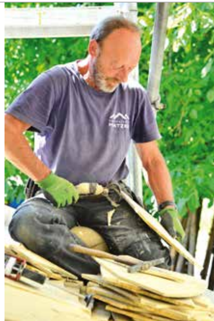
Es geht für Roland Laumeyer darum, die einzelnen Platten in die exakt passende Form zu bringen.
