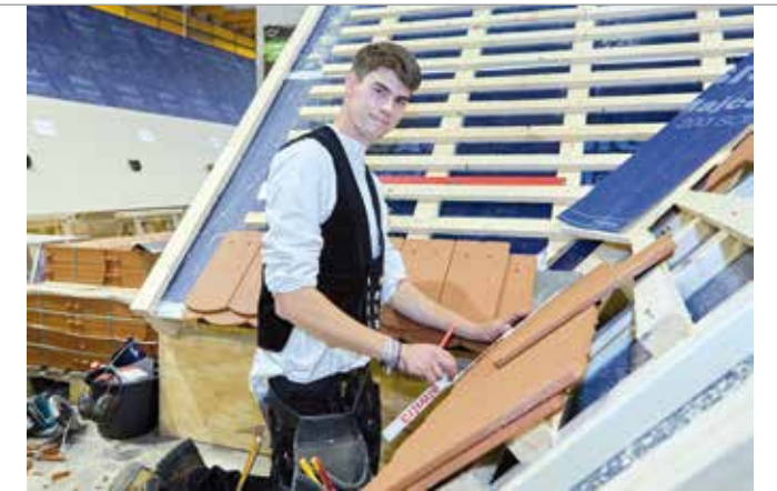
Der Drittplatzierte Jonas Christiansen arbeitet an seiner Hauptarbeitsprobe Biberschwanzdeckung.
