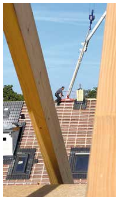
Ein Reinhard-Mitarbeiter beim Anhängen der Ziegelzange auf einer Großbaustelle in Köln.
