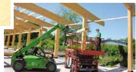
Dachdecker-geselle Bartels erklärt vor Ort, dass die riesigen KVH-Leimbinder in einem Stück geliefert und per Kran nach oben befördert wurden. Dort wurden sie unter anderem mit Koppelfetten befestigt und stabilisiert. Für Dach und Fassade der
