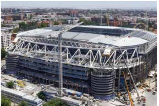
Langsam nimmt die Dachkonstruktion mit den Aluminiumprofilen Gestalt an.
