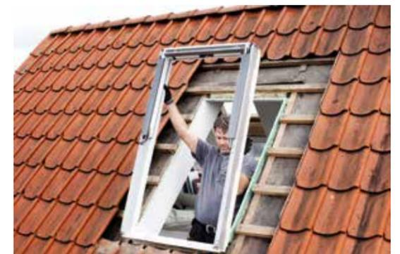
*Der Staat fördert den Austausch alter gegen neue Dachfenster mit energieeffizienter Verglasung, sodass Modelle mit besseren Wärmedämmwerten zu einem günstigeren Preis als Varianten mit Standardverglasung erhältlich sind.*
