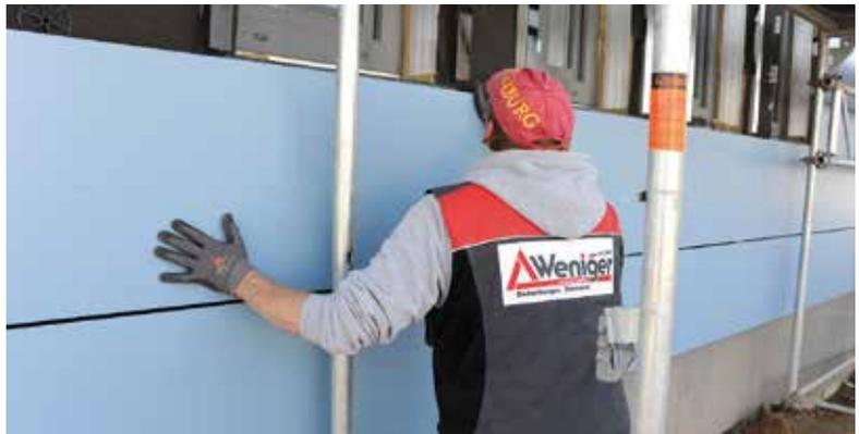
Es gilt, die Fassadenplatten genau zu justieren, bis alles fest verklebt ist.
