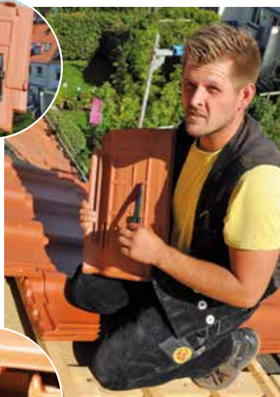
■ Einfache Verlegung mit dem neuen Nelskamp F12 mit Dachstick. Direkt unter dem Ziegel wird der Dachstick ausgeklappt.
