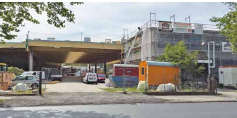
Größer und moderner zeigt sich bald die Niederlassung am Ostpreußendamm: Am zweiten Gebäude sind die Fassaden-, Putz- und Estricharbeiten sowie der Innenausbau in Ausführung. Die Dachabdichtungsarbeiten an der riesigen Dachfläche der Überdachung sind auch fast fertig und der Tiefbauer steht schon in den Startlöchern.
