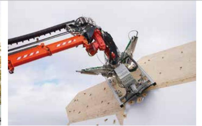
Der Roboter-Spinnenkran beim Einsetzen der Holzleichtbauteile.
